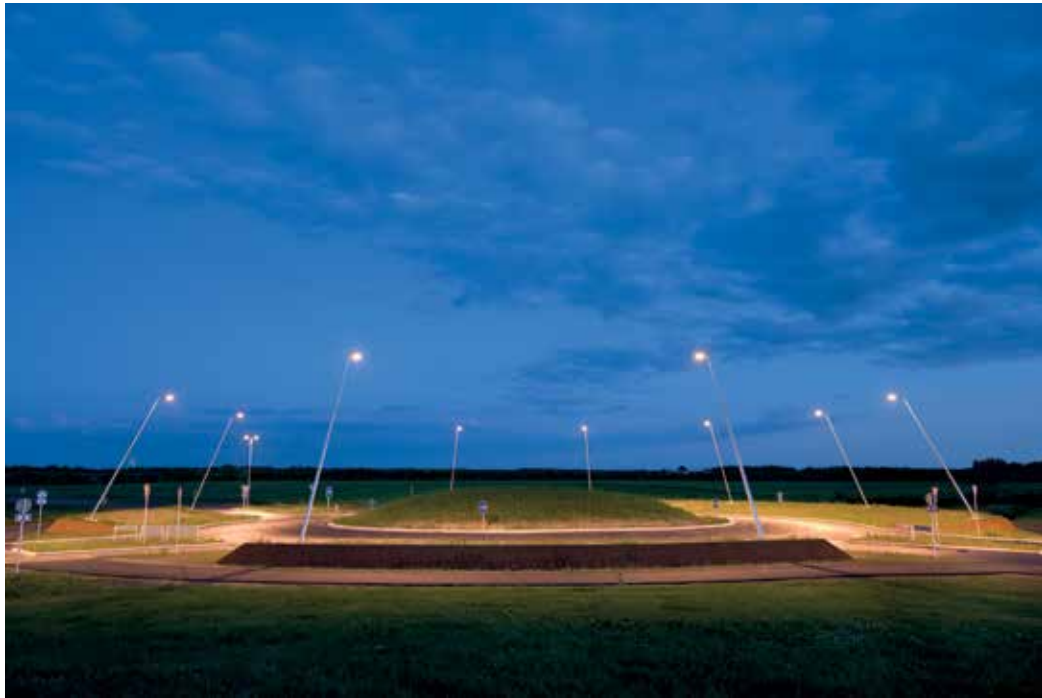
Ved Bramming har Preben Skaarup Landskab tegnet en rundkørsel, der er bygget op som ringe i vandet. Den præcise geometriske form gør anlægget stramt og let overskueligt og bevirker, at trafikanterne kan se, at de kommer til en rundkørsel. Foto: Philips Lys
