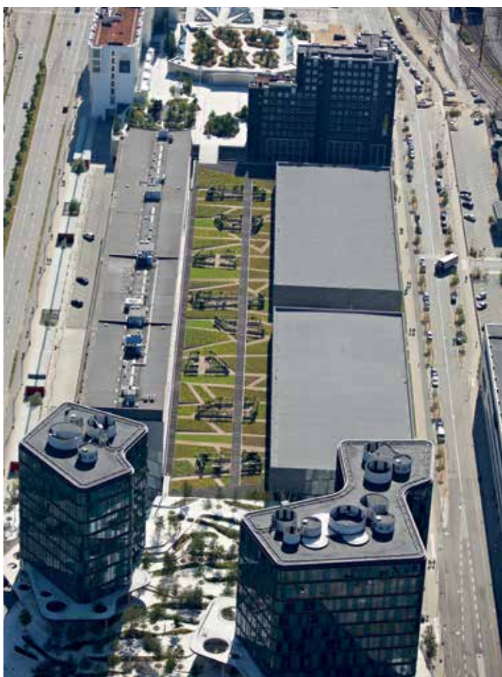
Grønne tage fungerer som en eng og kan optage 60-80 % af årsnedbøren. De optager, fordampner og forsinker regnvandet og aflaster derved kloakker og spildevandsanlæg for store mængder vand, hvilket i sidste ende forhindrer overløb og vand i gaderne. Her Rigsarkivets grønne tag tegnet af Schönher A/S. Foto: ABC Luftfoto
