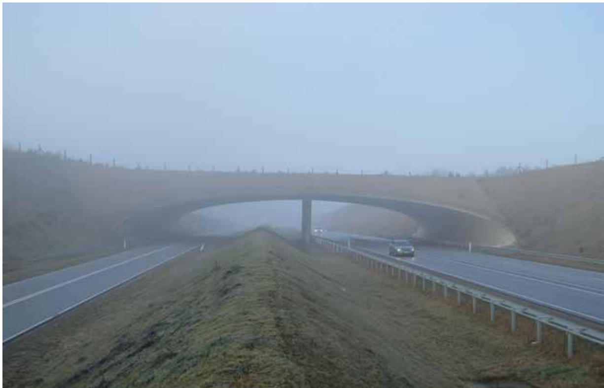
Ved anlæg og udformning af motorveje tager Vejdirektoratet arkitektoniske hensyn på linje med tekniske og funktionelle hensyn. Det gælder f.eks. markante visuelle elementer som broer, støjskærme, vejdstyr og beplantning. Her er det en fauna- og stipassage, tegnet af Bystrup Arkitekter. Foto: Bystrup Arkitekter
